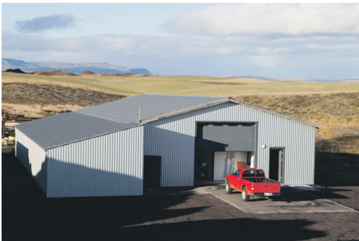
Regluverkið var þess valdandi að húsið er talsvert stærra en upphaflega var gert ráð fyrir.
