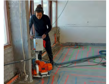
Gólfhiti, gólfhræsing fyrir 16 mm rör. Ryklaus gólfhitafræsing, verð á fermetra kr. 4.000 +vsk. Mætum hvert á land sem er, en fer þó eftir stærð verkefnis. Tilboð og upplýsingar á https://www.golffraesing.is s. 892-0808 - Oliver.
