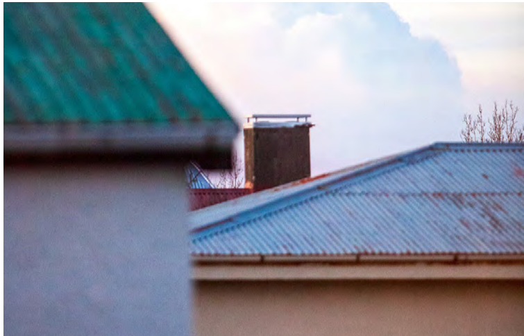
Almennar starfsvenjur við festingar á bárujárnsþökum eftir vindálagi eru; tvöfaldar naglaraðir á jöðrum og þrefaldar á hornum og ein þar á milli. Mynd / ál
