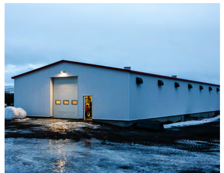
Nautahúsið er stálgrind klædd með yleiningum. Helmingurinn af byggingarkostnaðinum liggur í því sem er neðanjarðar, eða steiptum haugkjallara.
