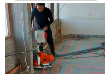
Gólfhiti, gólfþræsing fyrir 16 mm rör. Ryklaus gólfhitatræsing, verð á fermetra kr. 4.000 +vsk. Mætum hvert á land sem er, en fer þó eftir stærð verkefnis. Tilboð og upplýsingar á https://www.golffraeinging.is s. 892-0808 - Oliver.
