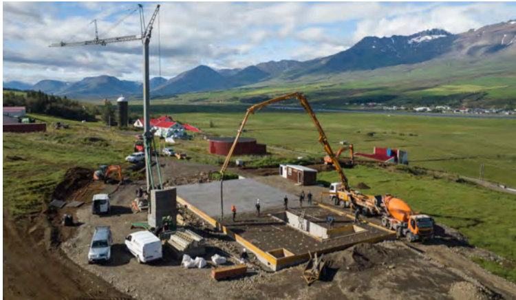
Á framkvæmdasvæði kornþurrkstöðvarinnar í Eyjafirði á þriðjudaginn. Mynd / Sigurgeir Sigurgeirsson
