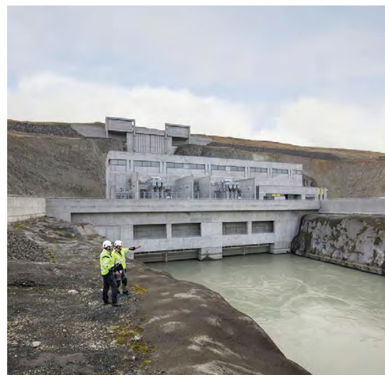
Búrfellslundur er ætlaður á stærsta vinnslusvæði Landsvirkjunar þar sem þegar eru sjö vatnsaflsstöðvar í rekstri. Búðarhálsstöð er ein þeirra, en hún er aðeins örfáa kílómetra í burtu.
