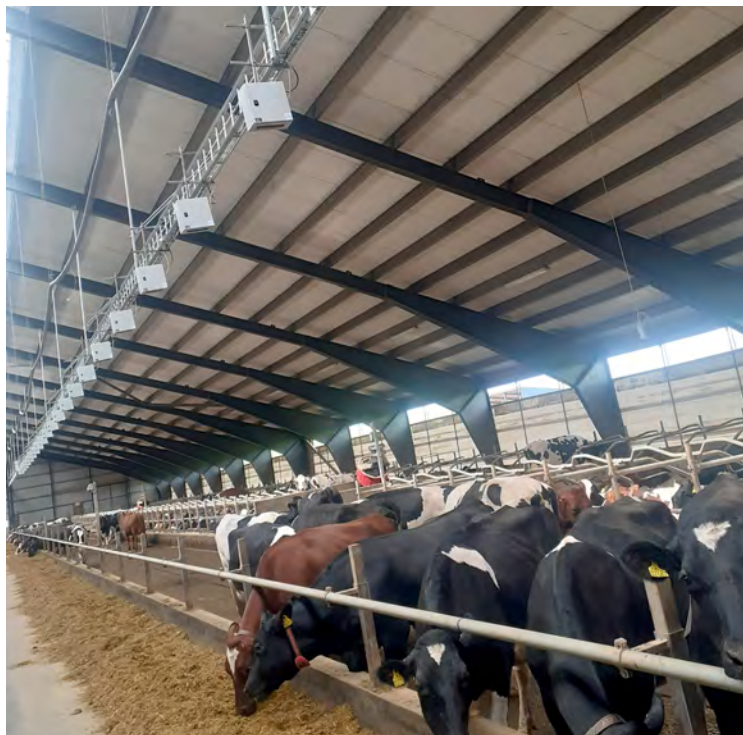
Úr fjósi í Danmörku. Myndavélar eru festar yfir fóðurgang í fjósi og eru partur af CFIT-kerfinu. Það tekur myndir af kúnum og fóðrinu við fóðurganginn en með því er metið hve mikið hver kúr étur, sem eru verðmætar upplýsingar bæði í bústjórn og til að meta fóðurnýtingu einstakra kúa.
