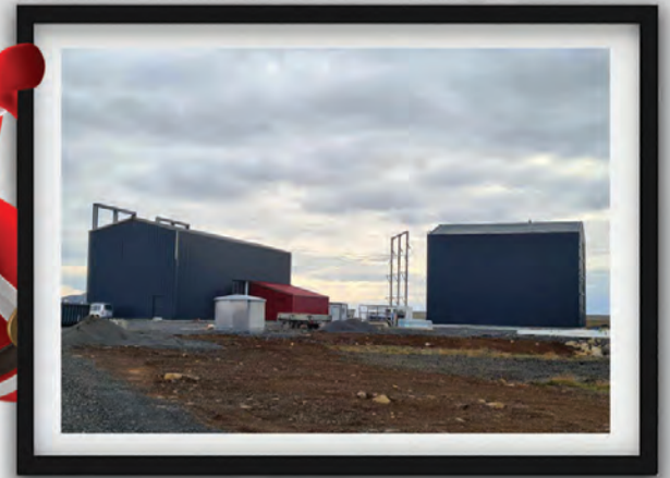
Landsnet hf. - Alverk Njarðvíkurheiði - Tengivirki og spennahús - "Í vinnslu"
