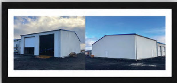
ESJ Vörubílar ehf. Selvík 1 - Viðbygging
