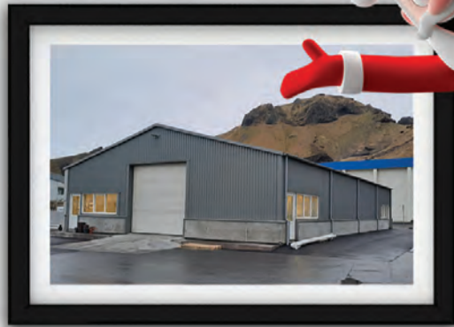
Skipalyftan ehf. Vestmannaeyjum - Iðnaðarhúsnæði
