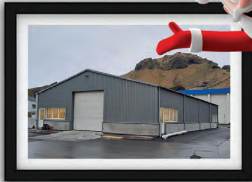
Skipalyftan ehf. Vestmannaeyjum - Iðnaðarhúsnæði
