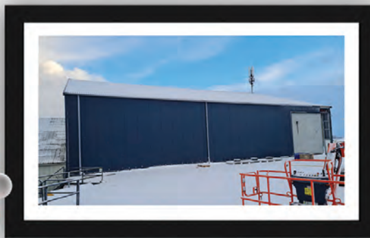
Terra Berghella 1 - Endurbygging á sorpflokkun
