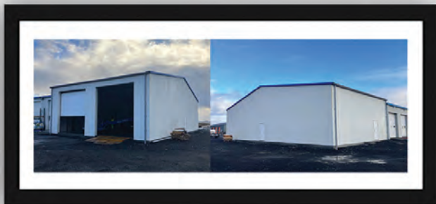
ESJ Vörubílar ehf. Selvík 1 - Viðbygging
